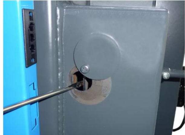
Exemplu pentru curățarea și eliminarea cenușei din căile de fum – partea inferioară
