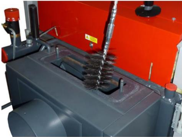
Exemplu pentru curățarea căilor de fum cu perie de sârmă – partea superioară
